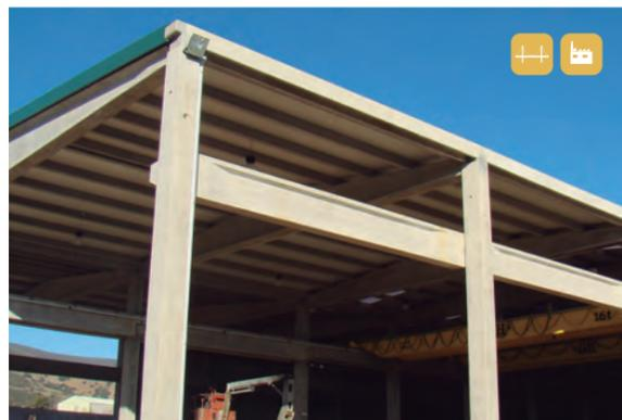
Viga 'I' en la estructura de un edificio industrial.
