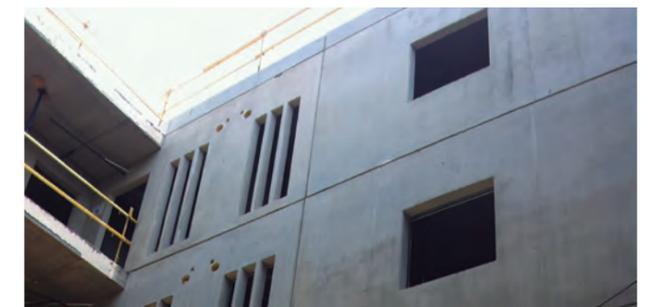
Edificio residencial con paneles prefabricados en la fachada.
