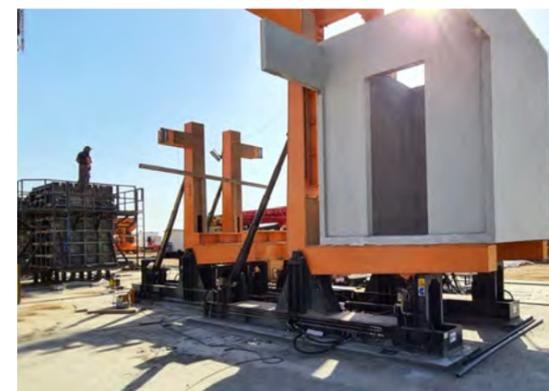
Elementos volumétricos prefabricados y preacabados (PPVC)
